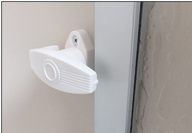
Fig. 64 Verrou rotatif pour sécuriser la porte de douche (exemple)
