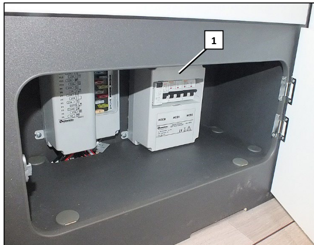
Abb. 97 230 V-Absicherung mit FI-Schutzschalter (Abb. beispielhaft)
