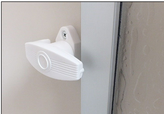
Abb. 64 Dreh-Riegel zur Sicherung der Duschtür (Abb. beispielhaft)
