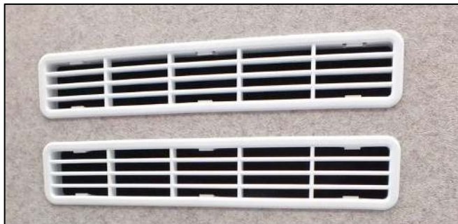
Abb. 107 Lüftungsgitter der Heizung (Abb. beispielhaft)
