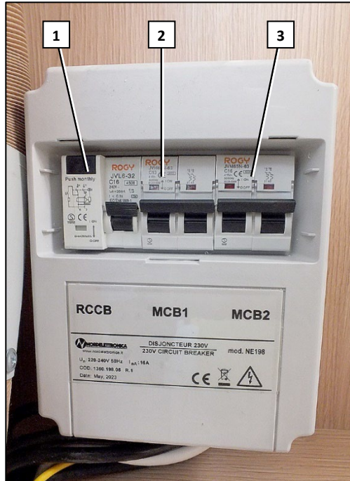
Abb. 98 230 V -Absicherung mit FI-Schutzschalter (Abb. beispielhaft)
